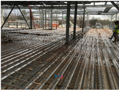
Elevated Decking & Slab Pour
