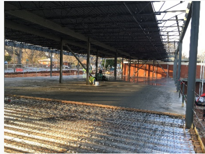
Elevated Decking & Slab Pour
